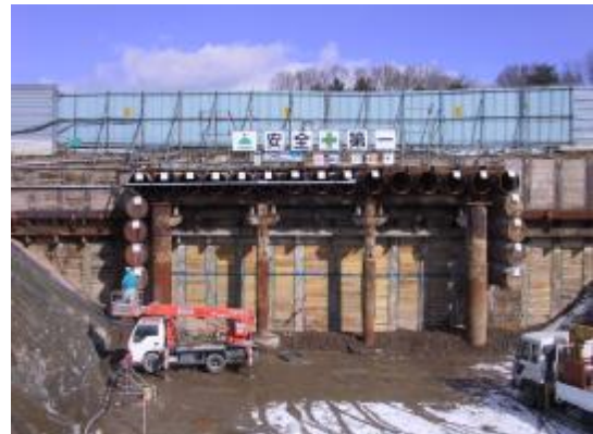
施工完了写真
